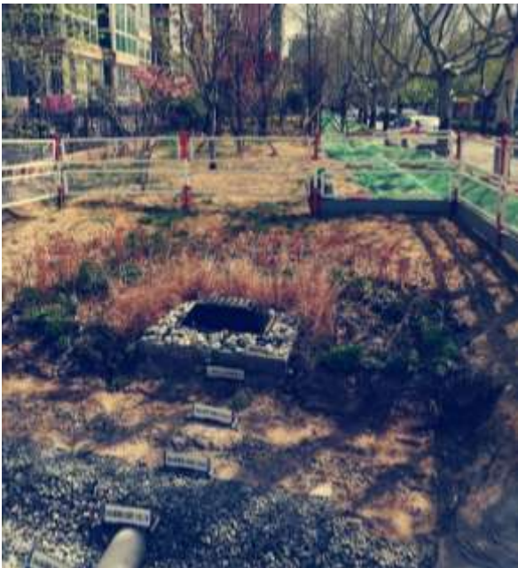
北京市通州区海绵城市小区，2018 年
