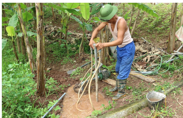
Erkundungsbohrung am Standort Ha Nam am Red River, 2019.
