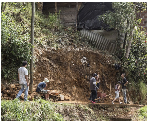
Hangrutsch in einer informellen Siedlung in Medellín.
