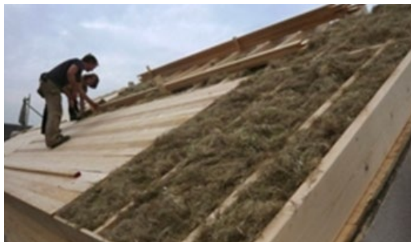
Dachdämmung mit Bastfasern.
